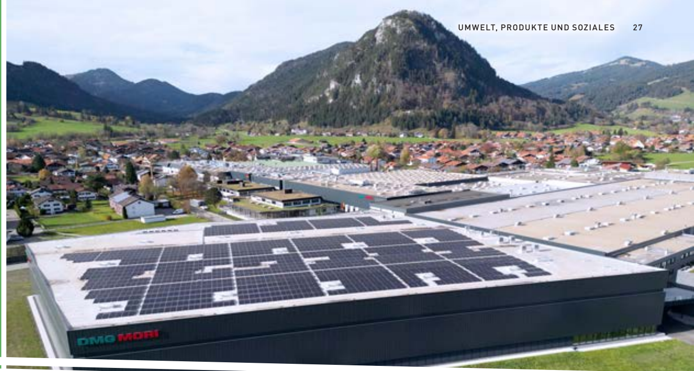
Grüne Energie: Mit weiteren Photovoltaik-Anlagen auf den Hallendächern unserer Produktionsstandorte, wie hier bei DECKEL MAHO in Pfronten erzeugen wir künftig noch mehr regenerative Energie für den Eigenverbrauch.
